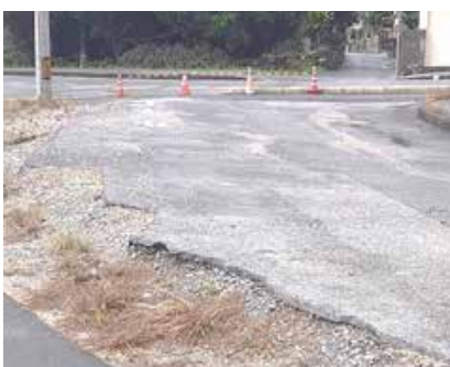
起点側残地状況
