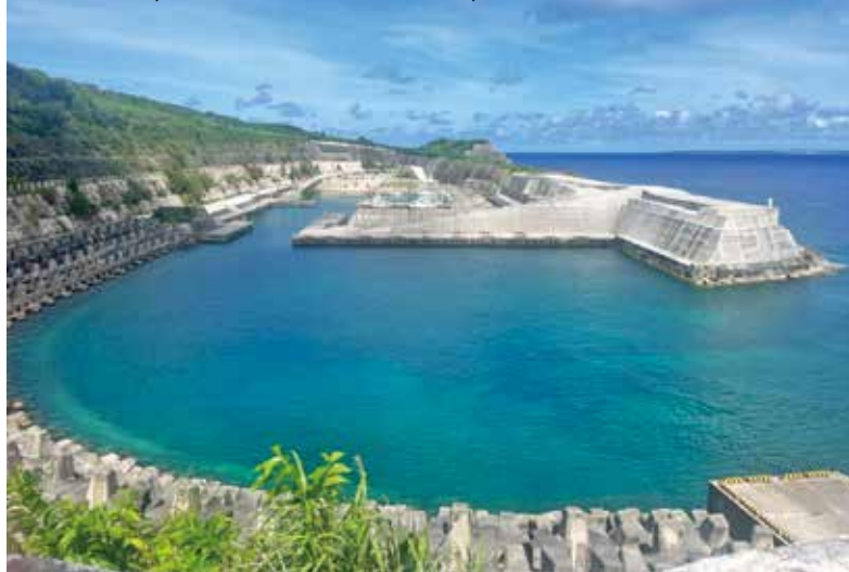
南大東漁港（島をくり抜いて作った避難港）
