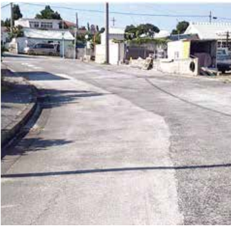
村道上仲田線終点側未改良区間
