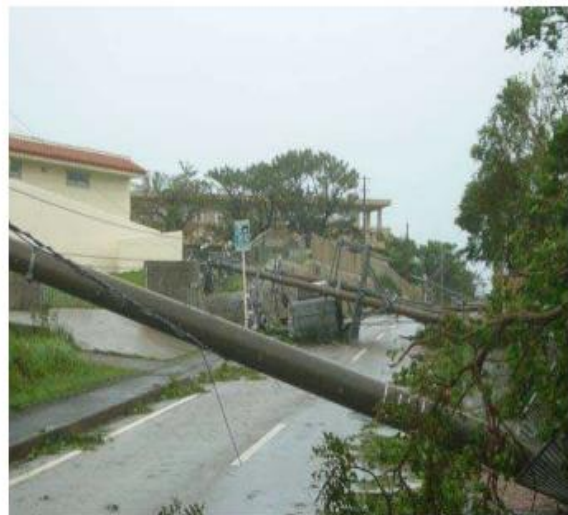
図 2-2 平成 18 年 台風 13 号（石垣市）
