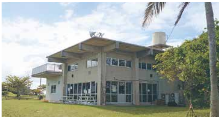
内花集落センター（内花公民館）
