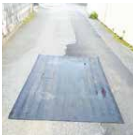
臭気の為、近隣住民によってシートをかけられた排水溝(仲田区)
